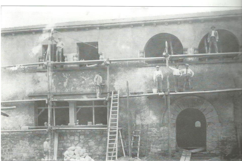
Anys 30 - Edifici de l'Escola i Capella de la Mare de Déu del Rosari (F. Sisquet)
