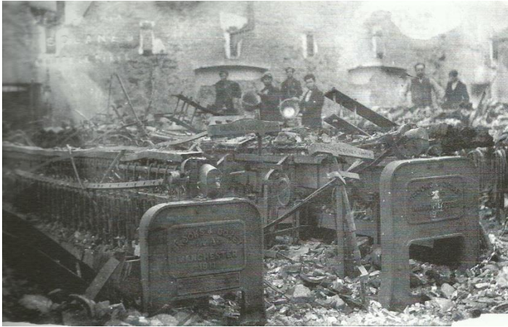
Fotografia de l'estat de l'interior de La Fàbrica després de l'incendi.
