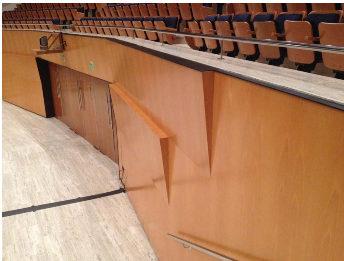
Fig. 2.14 - Fotografia dels elements acústics instal·lats per eliminar els ecos a l'escenari
